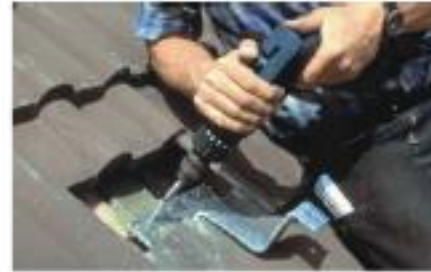
Mise en place des pattes de fixation
