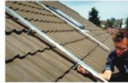
Installation des rails de fixation
